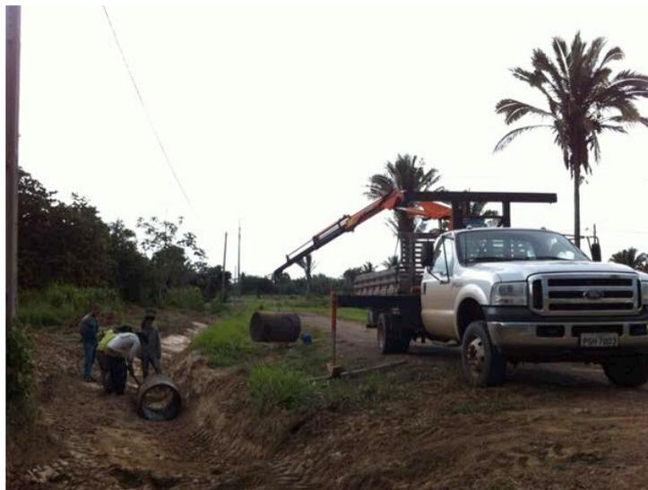
*Instalação de manilhas para acesso no canal de água.*
