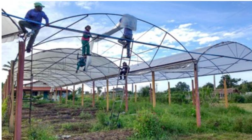
Devido ao longo período que as duas casas de vegetação permaneceram sem cobertura, realizamos uma nova pintura afim de eliminar as ferrugens instaladas na estrutura de ferro. Essa atividade é de suma importância, pois influencia de forma direta a durabilidade do plástico.
