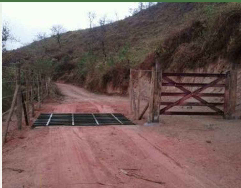
Serão concluídas as obras de 225 estruturas rurais
