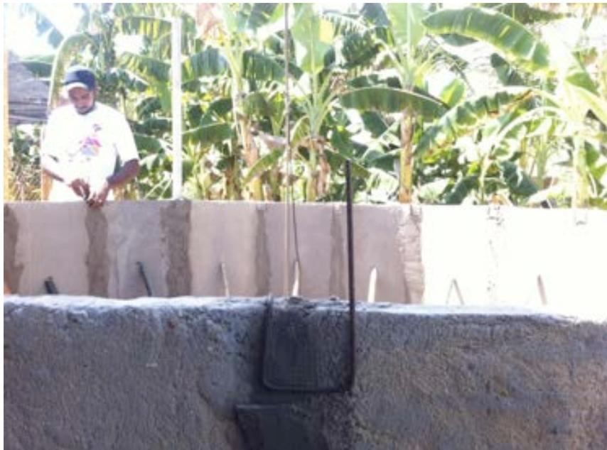
*Instalação do grampo de reforço, na união das placas*
