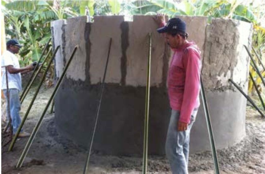
*Construção da cisterna com placas, acima do nível do solo*
