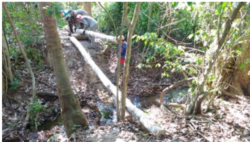
Alinhamento das vigas na construção das pontes
