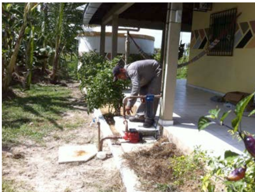
Instalação da bomba e filtro, interligando a rede de uso doméstico
