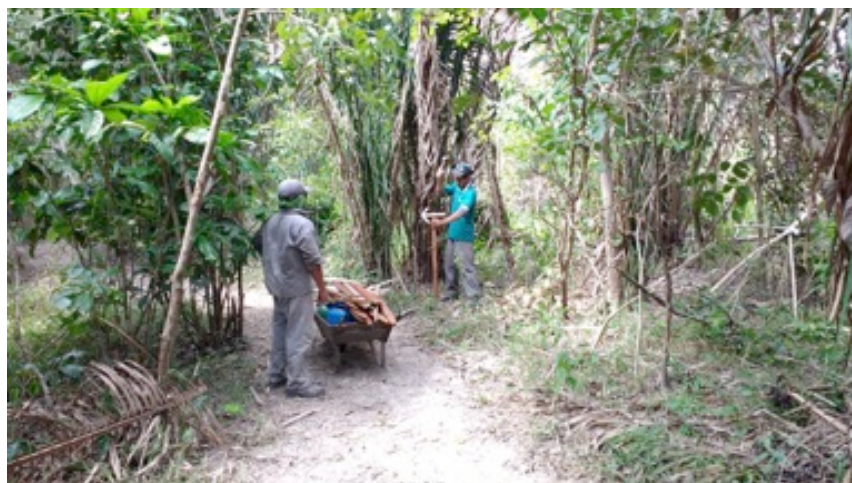
Instalação das setas de sentido de circulação da trilha
