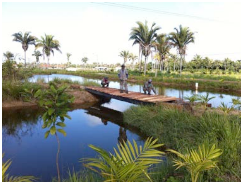
Construção da ponte de acesso à ilha
