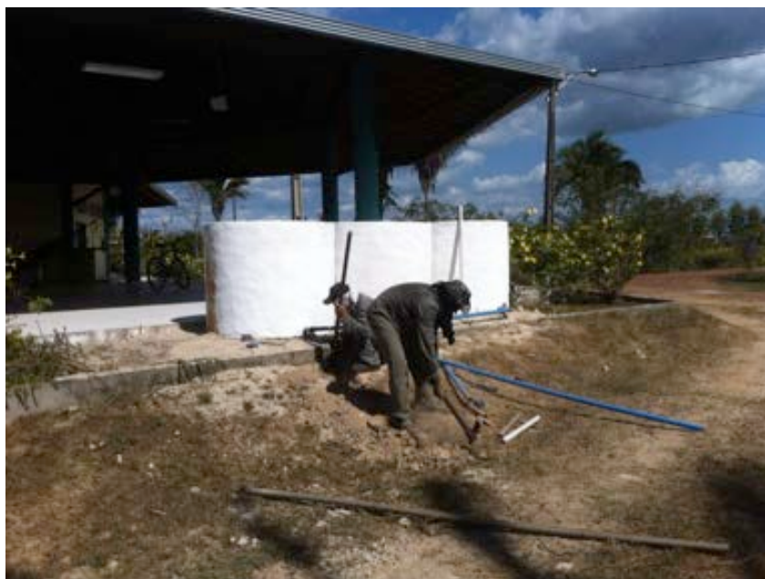
Instalação do sistema de irrigação por gotejamento nas áreas de citros na zona II.
