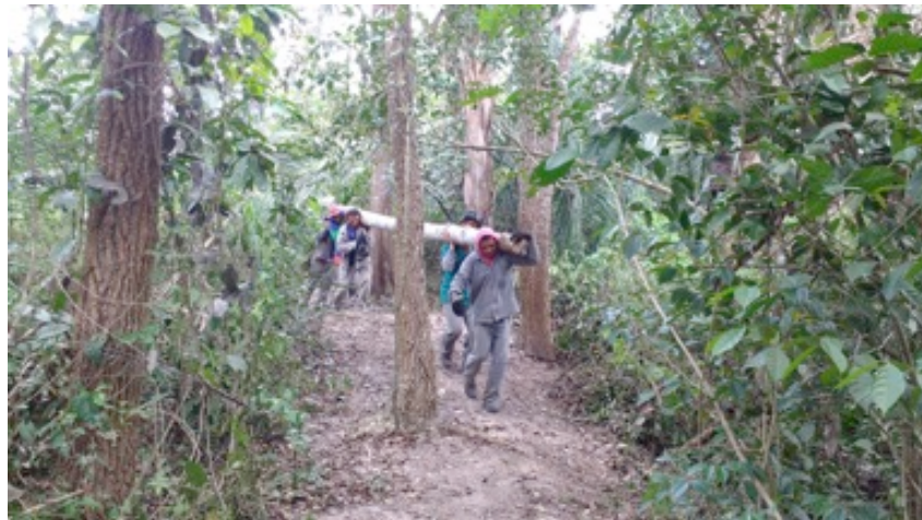
Transporte de madeira para construção das pontes da trilha
