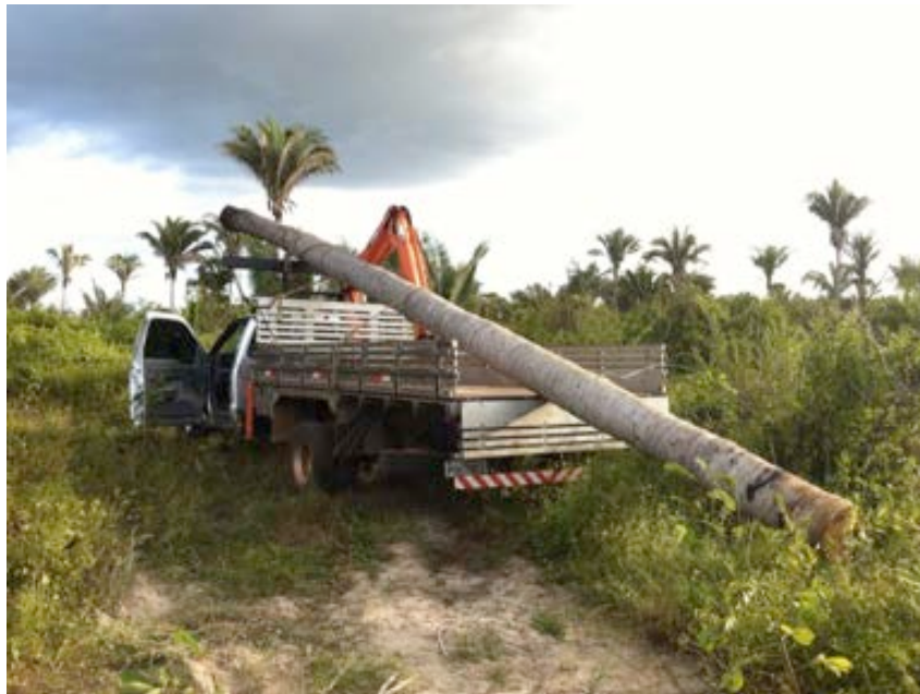
Transporte dos troncos de palmeiras, para construção da ponte
