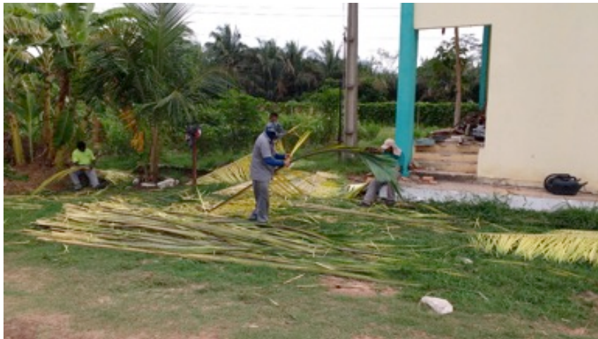
Abertura das palhas para cobertura do quiosque.
