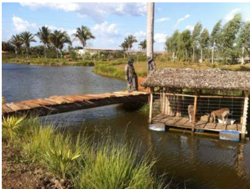
Construção da ponte de acesso à ilha dos porquinhos
