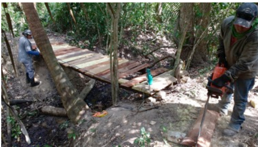
Confecção das pranchas de acesso sobre as pontes
